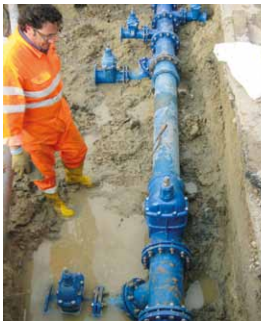
Cantiere rete idrica
