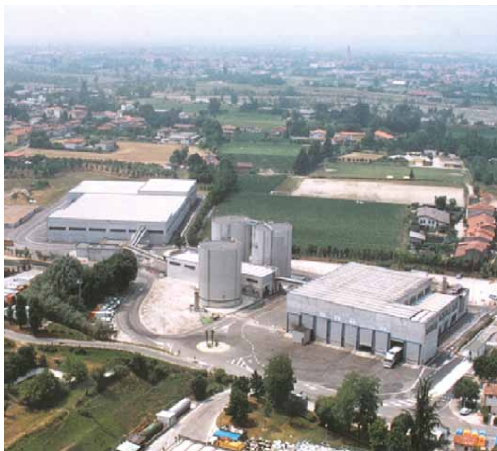
Complesso Polo rifiuti, Bassano del Grappa
