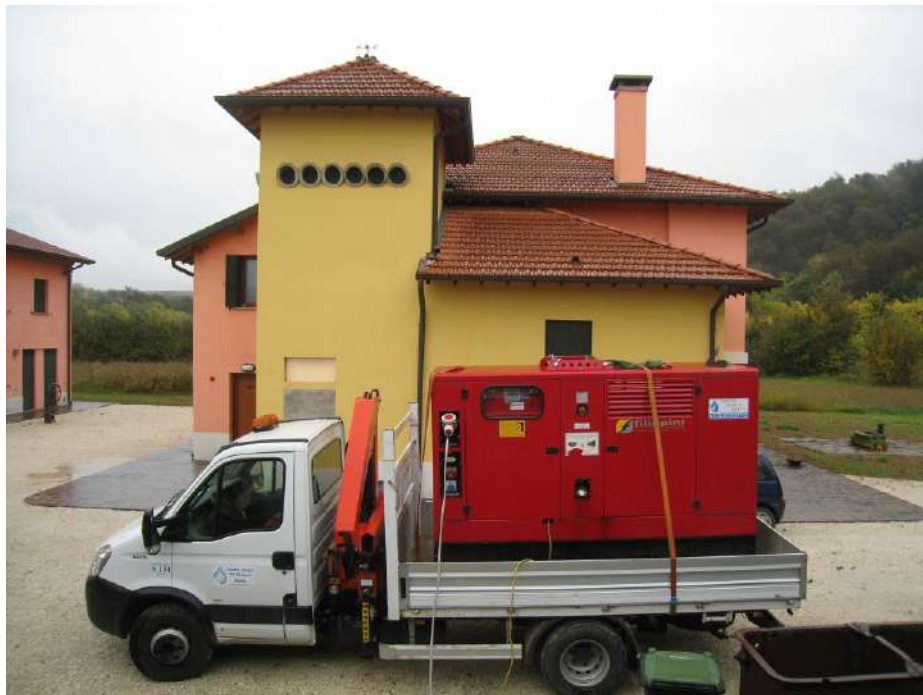
(Lavori fognari presso Valle San Giorgio di Baone - PD)
