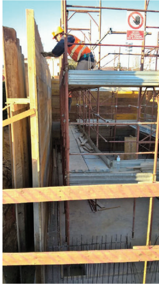
(Realizzazione impianto di in Comune depurazione di Orgiano – VI)
