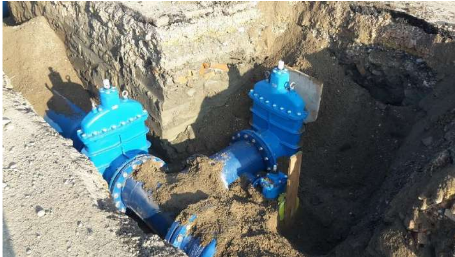
Lavori di sostituzione della condotta idrica in Comune di Anguillara Veneta tratto ex tabacchificio fino a scolo Monselesana – prog. n. 801/a
