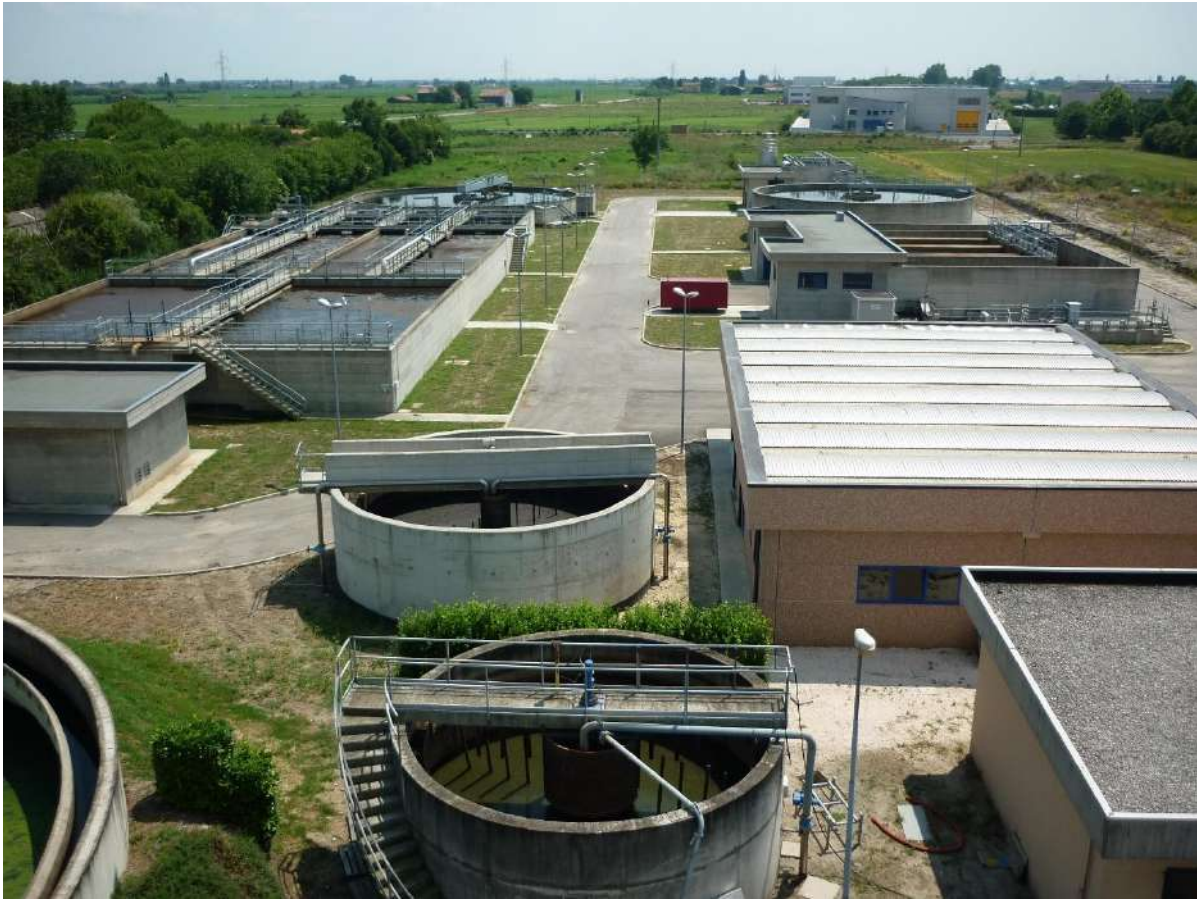
(Impianto di depurazione di Conselve - PD)
